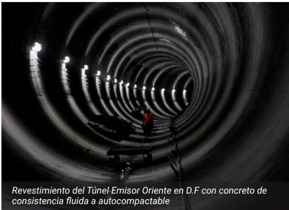
Revestimiento del Túnel Emisor Oriente en D.F con concreto de consistencia fluida a autocompactable
