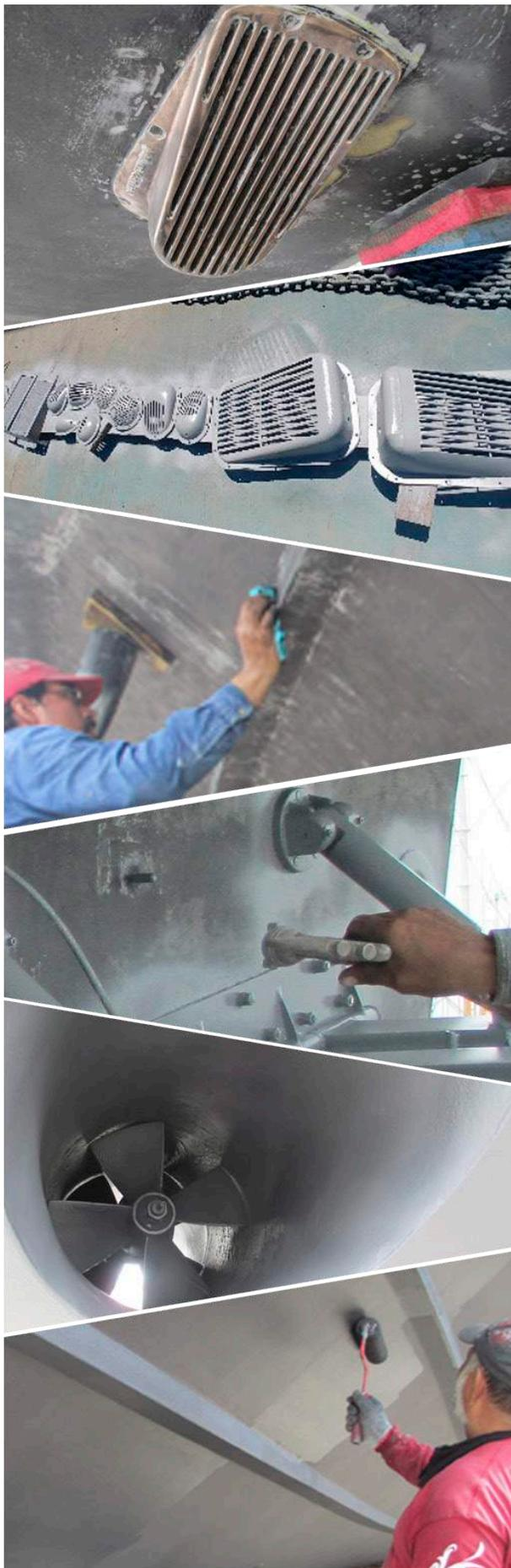
**MANTENIMIENTO A TRAMPAS:** Se desmontaron, arenearon y pintaron con una mezcla epóxica. Para los brazos y retenes se hizo un cambio de sellos; dichos sellos se elaboraron manualmente con un material especial llamado: empaque neopreno tramado de 1/8 de grosor.
